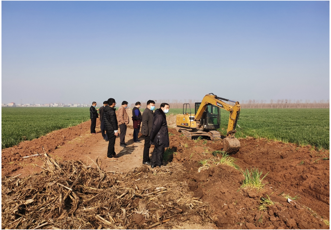
(现场办公照片)
